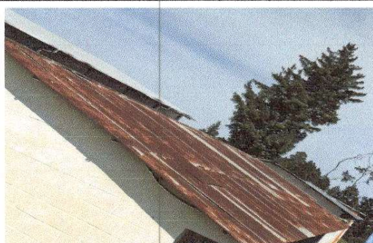
Foto 2: Sustitución de capote de lámina para lámina troquelada
