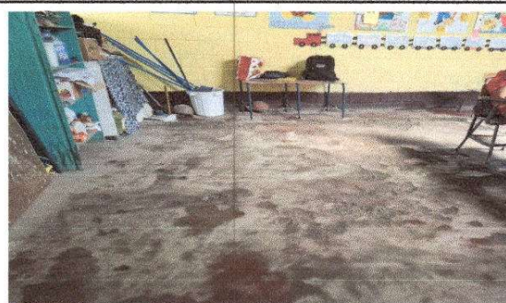
Foto 6: Sustitución de piso de torta de concreto por piso de granito
