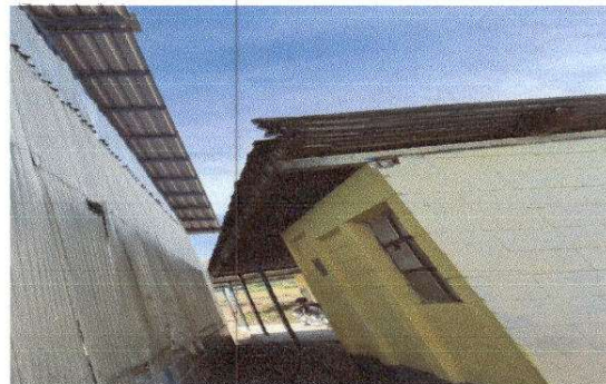
Foto 4: Sustitución de canal de pvc
