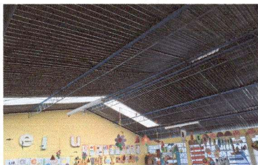
Foto 3: Mantenimiento a estructura de soporte de metal
